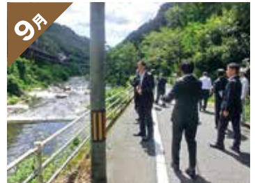
9月 呉平谷線工事現場を視察
